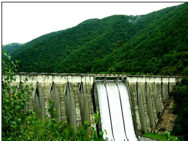
Barajul hidrocentralei de la Gura Râului
