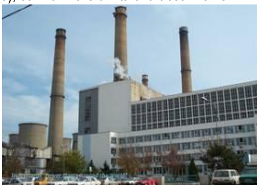
Fig. 3 Centrala Luduș-Iernut (puterea instalată: 800 MW)
